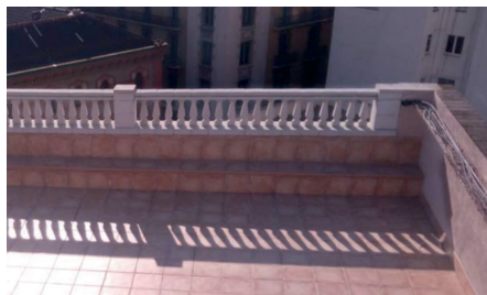
Exemple de banc perimetral
